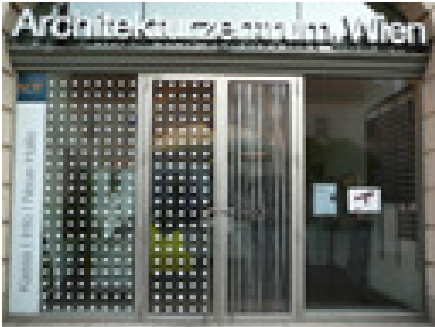
Abbildung 3: Mit Punktmuster markierte Glasfläche. (aus WUA 2014))
