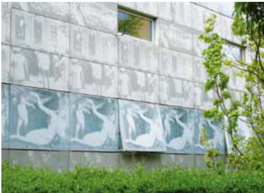
Abbildung 2: Hochschule für nachhaltige Entwicklung Eberswalde (HNE) mit flächig bedruckten Fenstern und Fassadenteilen (Quelle: LINDEINER ET AL. 2010)
