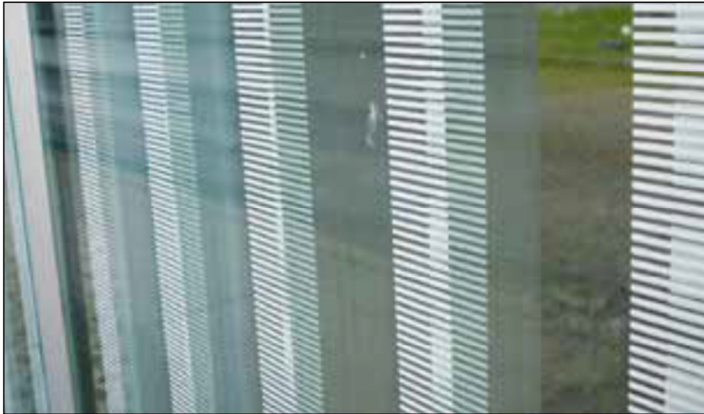
Abbildung 1: Siebdruck auf Glasfläche (Quelle: LINDEINER et al. 2010) 2 cm breite unterbrochene Streifen in 10 cm Abstand – wurde beidseitig aufgebracht und teilweise auf der Rückseite etwas verbreitert, was bei der Annäherung den 3D-Effekt verstärkt
