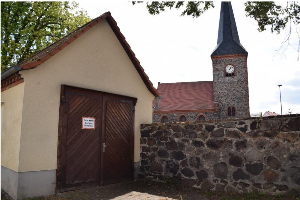
In der Trauerhalle stehen 20 Sitzplätze zur Verfügung. Es ist kein Stromanschluss vorhanden und damit auch keine Beleuchtung oder Beheizung möglich. Die Trauerhalle befindet sich in einem baulich guten Zustand. Zur Vermeidung von Witterungsschäden sollten die Türen und Holzbalken des Vordaches neu gestrichen werden. Am Dach sind kleinere Erhaltungsmaßnahmen zu erwarten.
