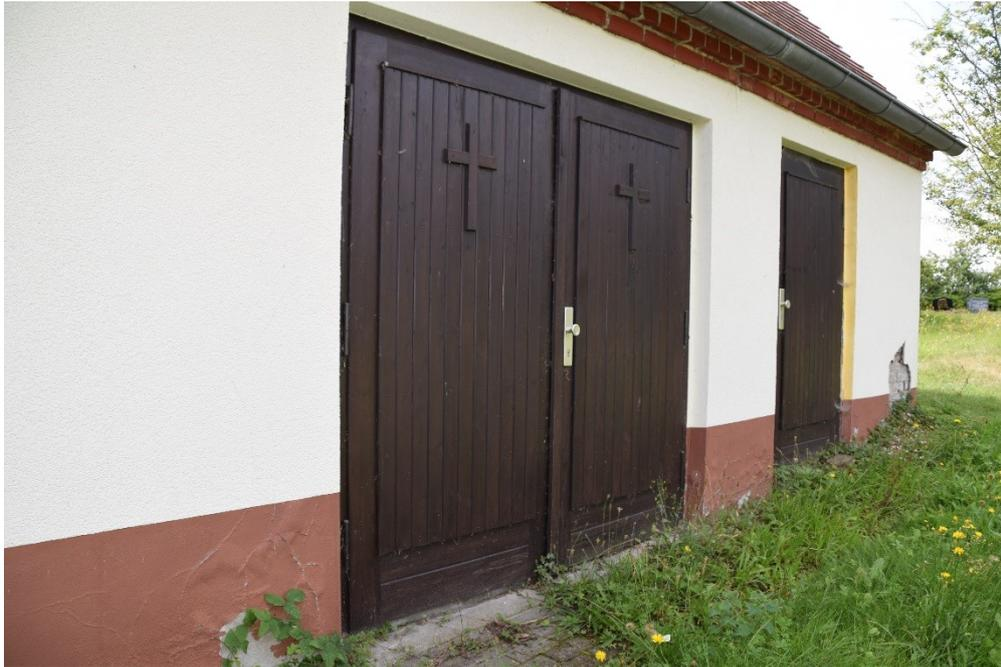
Das Dach ist in ausreichend guten Zustand. Die Türen wären zur Vermeidung von Witterungsschäden am Holz neu zu streichen.
