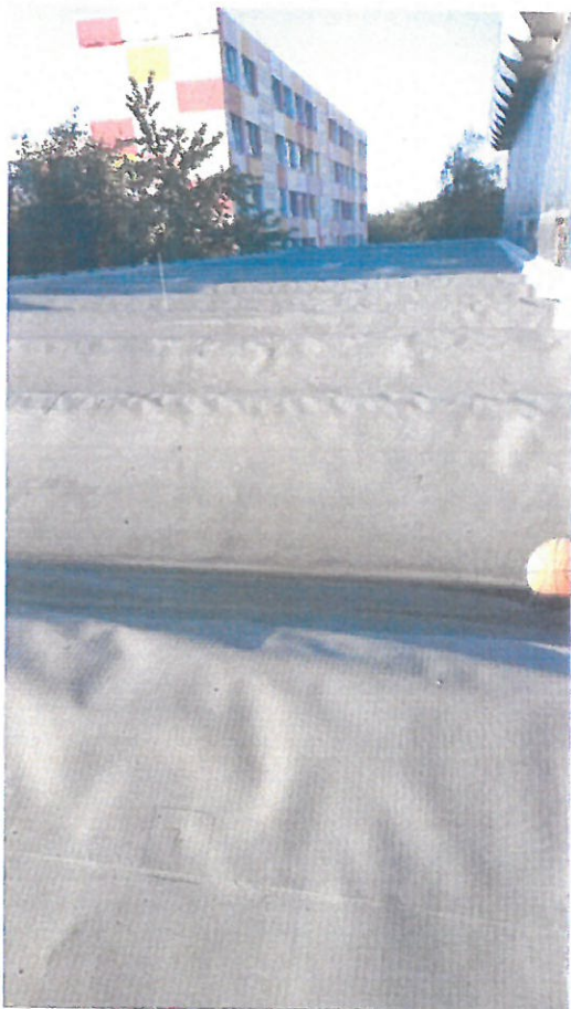
Dachabdichtung auf dem Funktionalanbau
