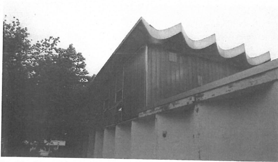
Süd-Ost-Ecke des Hallengebäudes
