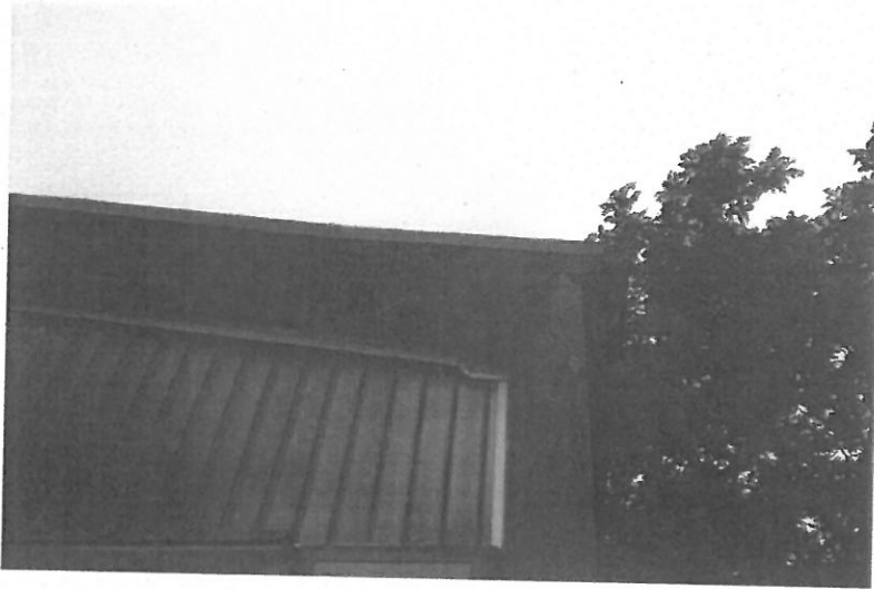
Deckenaufleger nordwestliche Gebäudeecke
