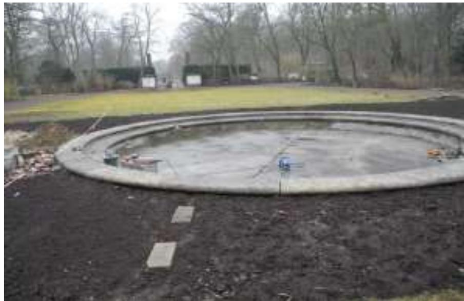
Zunächst wurden die alten, bereits lockeren Fugen am Brunnen entfernt und anschließend wieder mit Mörtel verschlossen und abgedichtet. Die sich bereits in der Bodenplatte befindlichen Risse wurden mit Epoxidharz verschlossen. Das alte Abflussrohr wurde neu einbetoniert. Weiterhin wurden die neue Bodenöffnung für die Düse sowie der Unterlauf für die neue Wasserleitung ausgehoben.
