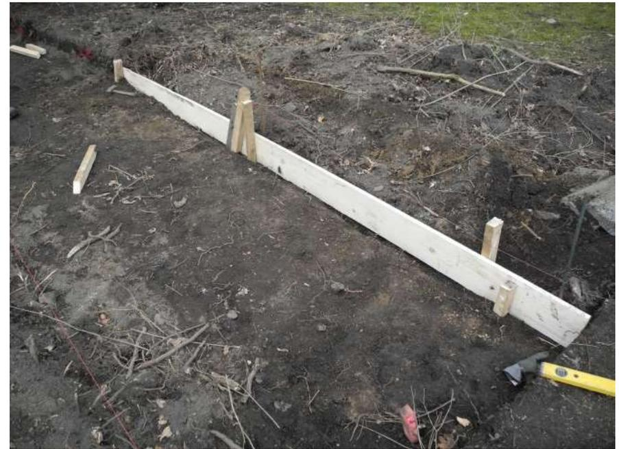
Auf beiden Wegseiten erfolgte die Bereinigung von Busch- und Wurzelwerk sowie die Ausschachtung der Wegflächen auf 1,5 m Breite und 20 cm Tiefe. Hierfür wurde ein Minibagger verwendet. Nach der maschinellen Grobschachtung folgte die manuelle Feinschachtung. Die exakte Führung der Kreisbögen wurde durch Holzborde erreicht.
