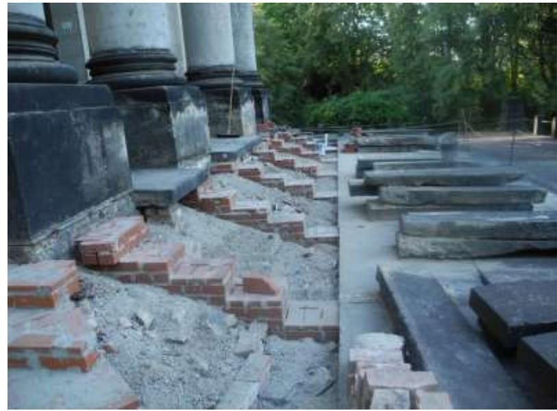
An der Treppe wurden lose Gesteinsschichten abgetragen, die kaputten Stufen aus der Treppe herausgezogen und beschriftet. Somit wurden alle kaputten Steinstufen zur Abholung zwecks Reparatur beim Steinmetz vorbereitet. Parallel wurde damit begonnen, die maroden Wangen wieder aufzumauern. Hierbei wurden alle Wangen soweit vorbereitet, dass sie direkt tragfähig und bereit zur Aufnahme der Treppenstufen sind.
