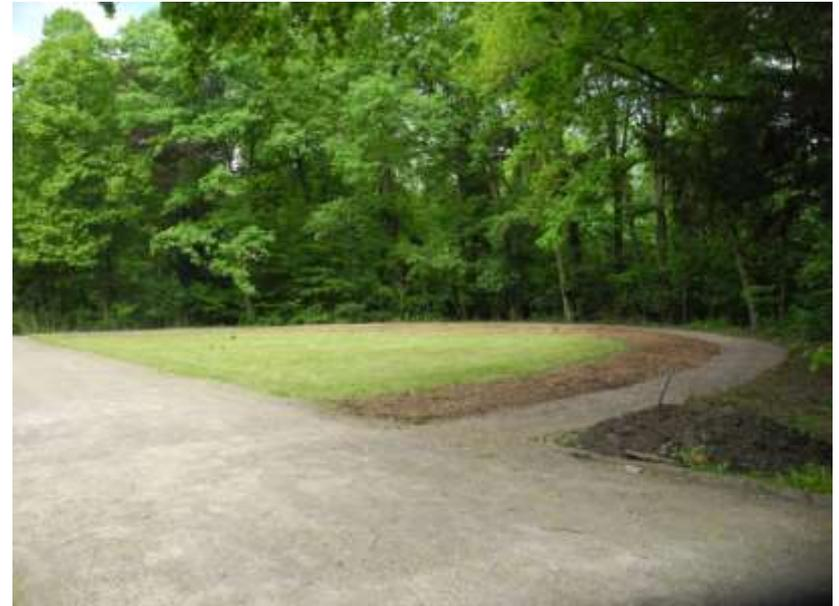
Nach der weiteren Verdichtung des Füllmaterials wurde roter Splitt aufgetragen, der den Oberflächenabschluss bildet. Im Anschluss wurden die Übergänge der Bögen zur Wegführung egalisiert. Auf der Außenseite erfolgte die Aufschüttung der Bögen zwecks Stabilisierung. Die Rasenfläche auf der Innenseite der Bögen wurde mit Rindenmulch bedeckt, um einen sauberen Abschluss zur Rasenfläche zu erreichen.
