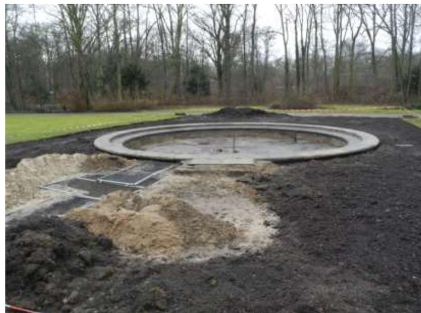
Vor der Instandsetzung wurde der vorhandene Brunnenschacht zurückgebaut und durch einen neuen Pumpenschacht ersetzt. Das alte, im Brunnen befindliche Brunnenrohr wurde ebenfalls entfernt. Weiterhin wurde das Areal um den Brunnen weiter mit Erde aufgefüllt, die gleichzeitig verteilt und an die Rasenkante angepasst wurde.
