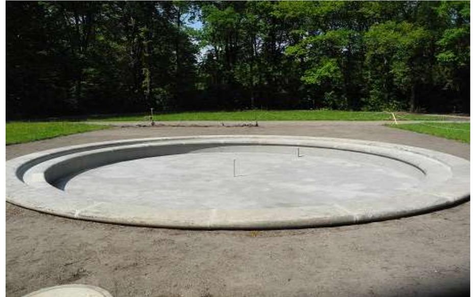
Die restliche Brunnenwand wurde mit Saniersperrputz verputzt und der Schacht für das Wasserrohr zubetoniert. Zudem wurde der Brunnen vom restlichen Schutt und Staub gereinigt und anschließend die Risse mit Epoxidharz aufgefüllt. Hier wurde auf das Epoxidharz Armierungsgewebeteile gelegt, durch die weitere Risse vermieden werden sollen. Abschließend wurde der Grund des Brunnens mit einer Schicht Zementmörtel überzogen, um den Brunnen dichter zu machen und Unebenheiten auszugleichen.
