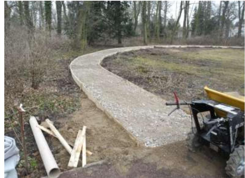
Die Fichtenholzborde wurden auf die Höhe des vorbeiführenden Hauptweges ausgerichtet und im Boden befestigt. Im Anschluss wurde der Weg ausgeschachtet. In die Wegflächen wurden Estrichsand, Fließ und Schotter eingebracht sowie Unebenheiten beseitigt.
