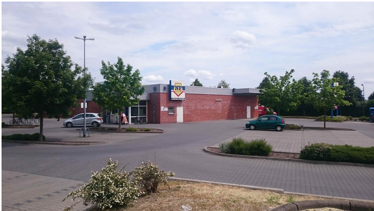
Abbildung 2: Vorhabenstandort mit Bestandsgebäude an der Heidestraße/Südstraße
