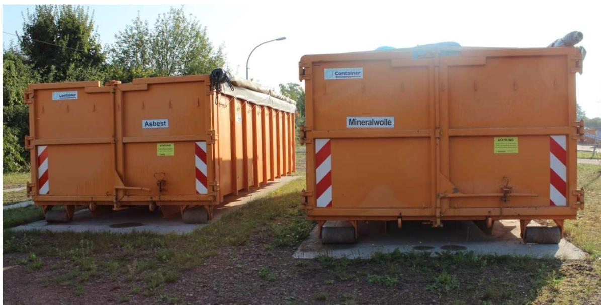
**Abb. 10: Sammelstelle für asbesthaltige Baustoffe und Dämmmaterial aus gefährlichen Stoffen**
