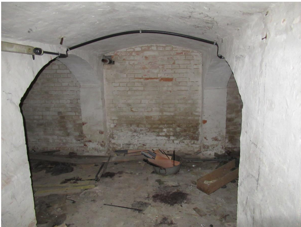
Abbildung 10: Keller, vollständig verputzt mit tlw. offenen Böden
