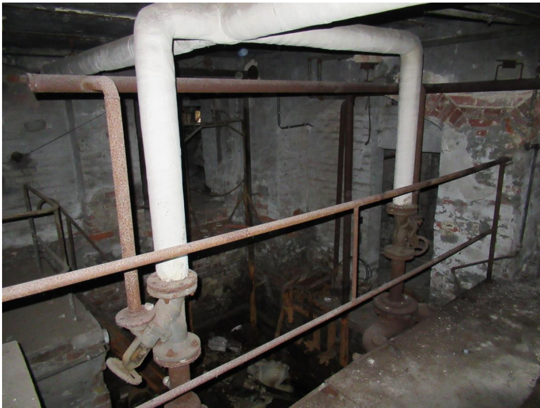
Abbildung 11: Kellerräume mit Versorgungsleitungen
