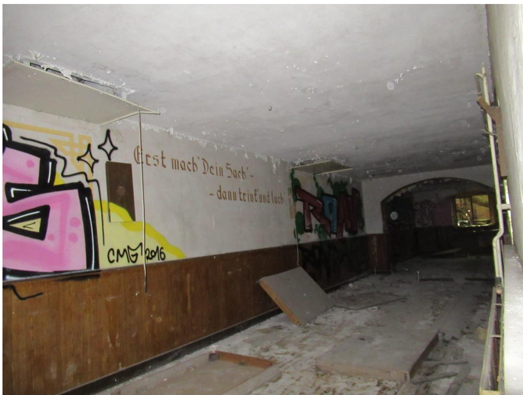
Abbildung 13: Ehemaliger Kegelbahn im Keller
