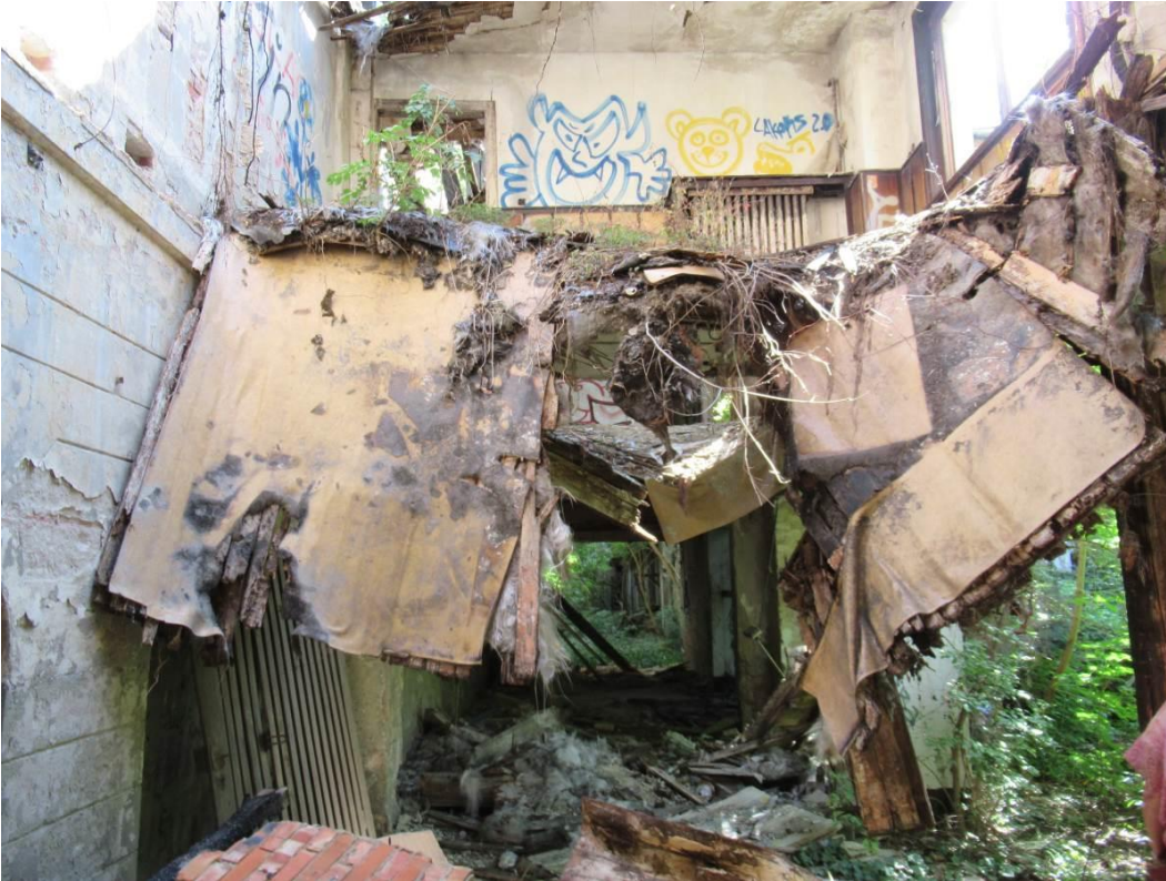
Abbildung 7: Eingangsbereich von der Zerbster Straße aus
