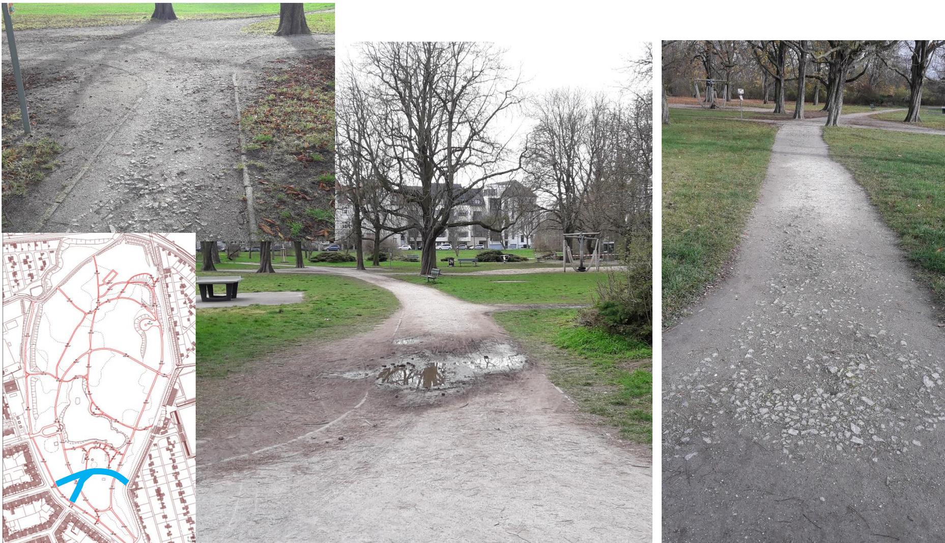
Bsp. freigelegte Tragschicht, überlagerte Wegeinfassung, Pfützenbildung an stark frequentierten Abschnitten
