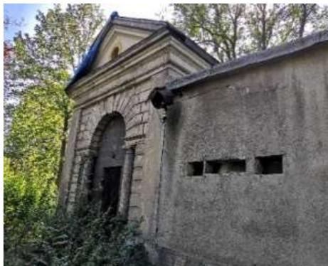
**Ist:** Das alte Wachhäuschen befindet sich am Rande des Parks und ist in einem baulich bedenklichen Zustand. Das Bauwerk wurde von der Vegetation befreit und die vorhandenen Fragmente der Kolonaden wurden gesichert.
