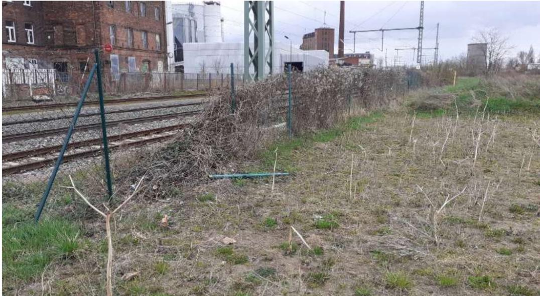
defekter Maschendrahtzaun zum Bahngelände (DB Netz AG) – Reparatur an ca. 2 Feldern erforderlich
