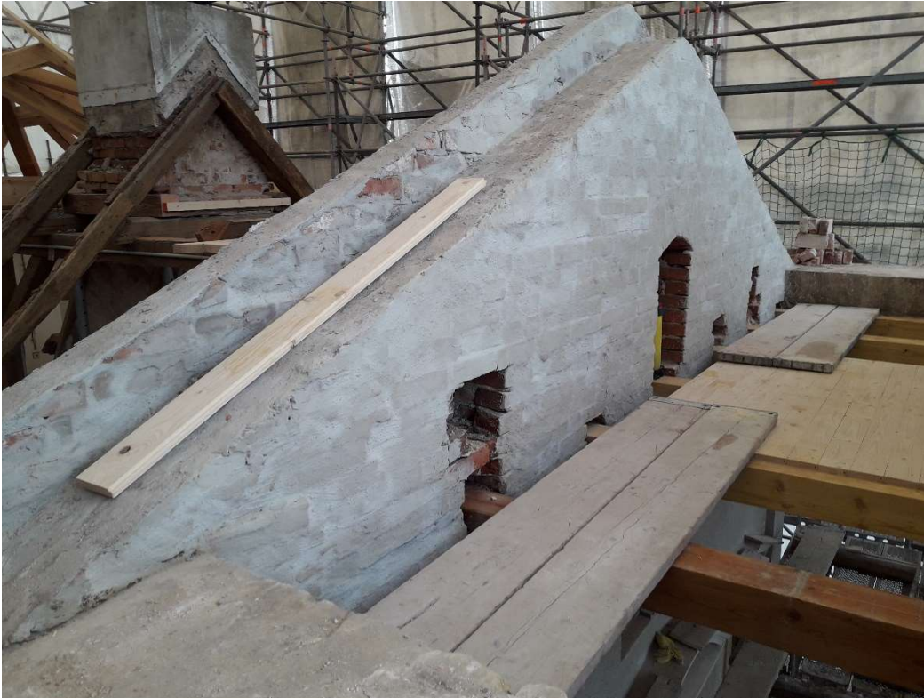
Portikus: Erneuerung Dach und Decke
