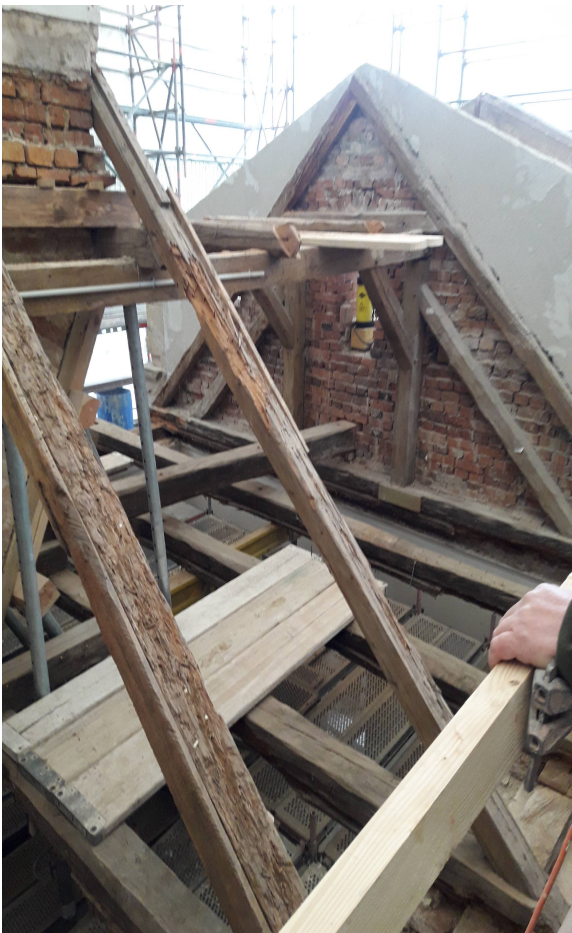
Mittelsegment: Erneuerung Dach und Decke
