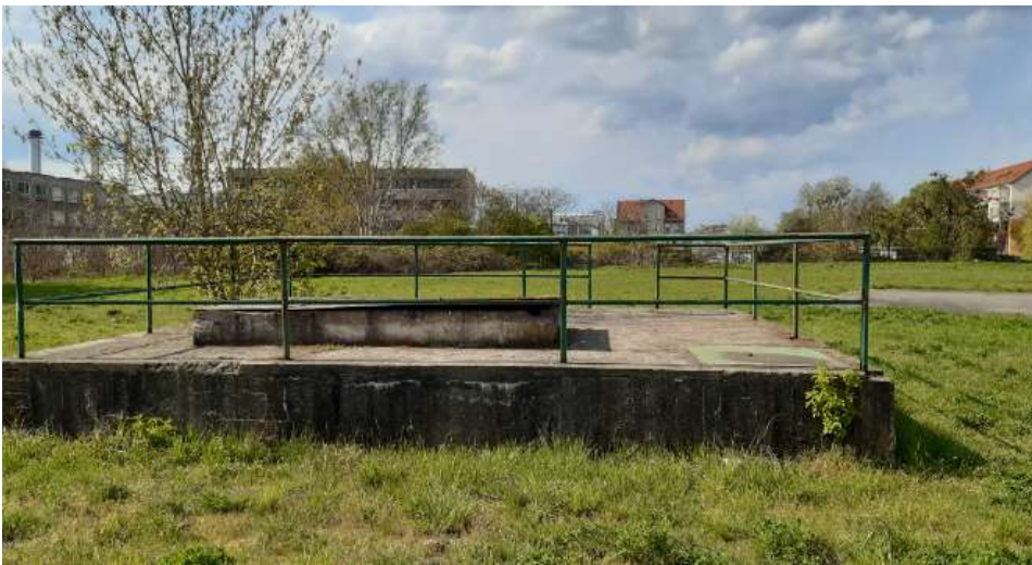
DVV-Bauwerk der Fernwärme-Versorgung
