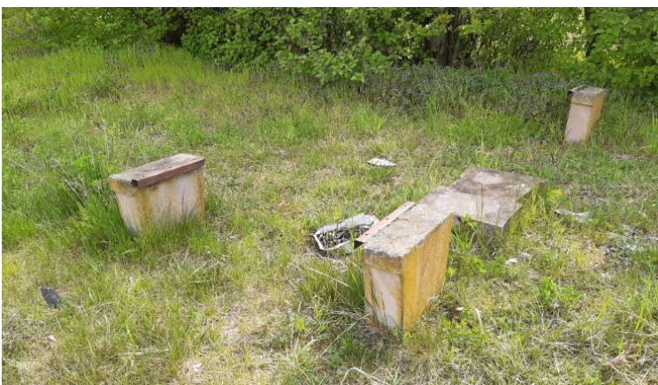
Betonfüße für Hockerbank – Montage Bankauflage möglich
