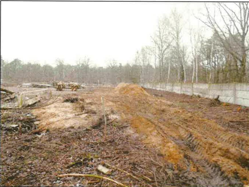
**Abbildung 4** Östliche Grundstücksgrenze mit nach Fällung verbliebenen Stubben (rechts im Bild), durch Wurzelziehung angefallenem Sandhaufen und Resten der abgerissenen Bebauung (links)
