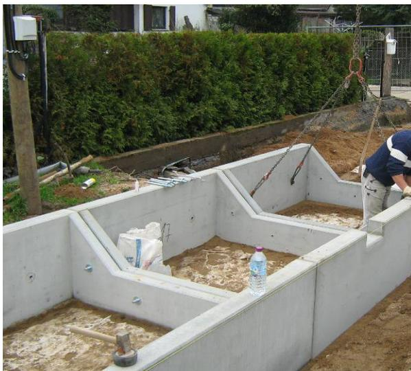
**Abb. 4:** Innodrain-System während des Einbaus 2009 im Füllerkamp in Braunschweig
