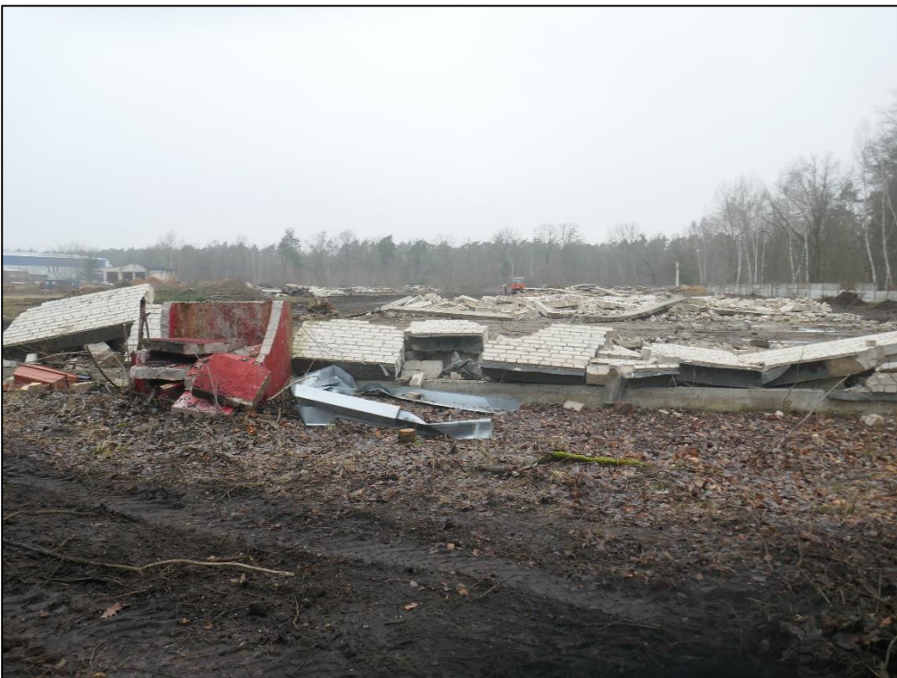
Abbildung 4-7 Vorgezogener Rückbau der östlichen Fahrzeughallen
