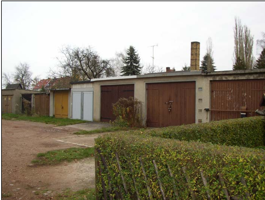
Abbildung 5 Garagen innerhalb der Kleingartenanlage
