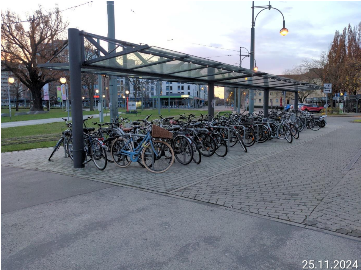
Überdachte Fahrradabstellanlage am Hauptbahnhof
