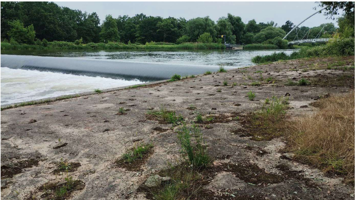
Abbildung 8: Wehrwange mit Muldewehr (Foto: Stadt Dessau-Roßlau)
