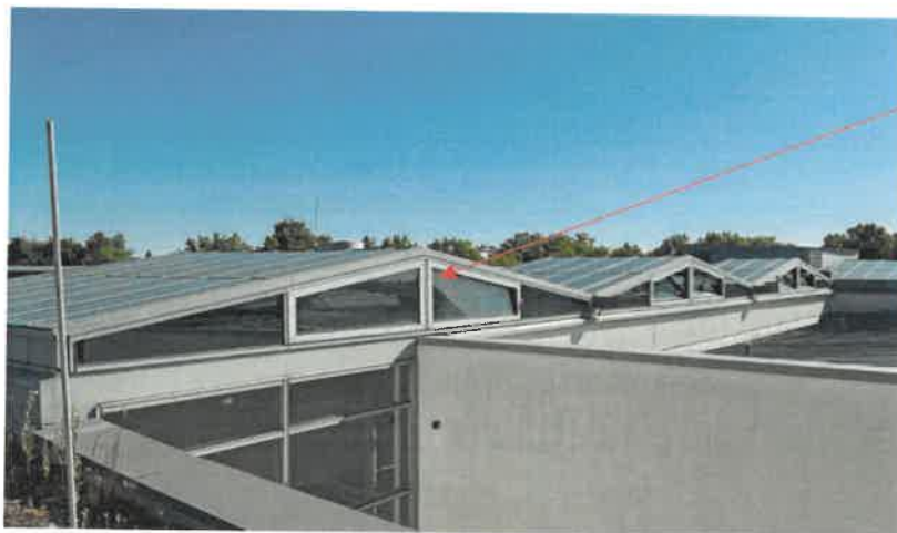
Fassadenansicht Lichthof – Dachebene
