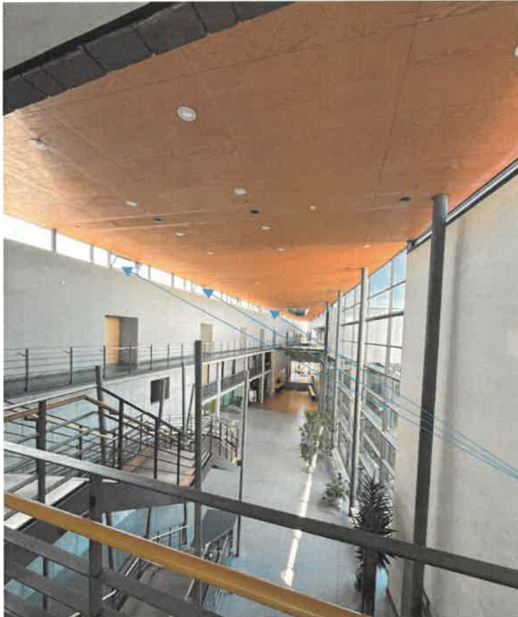
Vorhandene RWA- Abluftöffnungen
