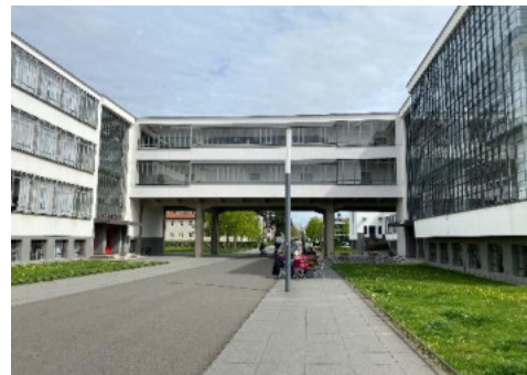
Abb. 61 Blick auf das Bauhausgebäude (von Bauhausstraße) (Foto: complan Kommunalberatung GmbH)
