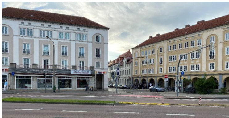
Abb. 32 Wohnungsbau der 1950er Jahre an der Kavalierstr./Ecke Ferd.-von-Schill-Str. (Foto: complan Kommunalberatung)
