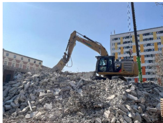
Abb. 41 Abriss eines Wohnblocks in der Ferdinand-von-Schill-Straße im Jahr 2024 (Foto: complan Kommunalberatung GmbH)
