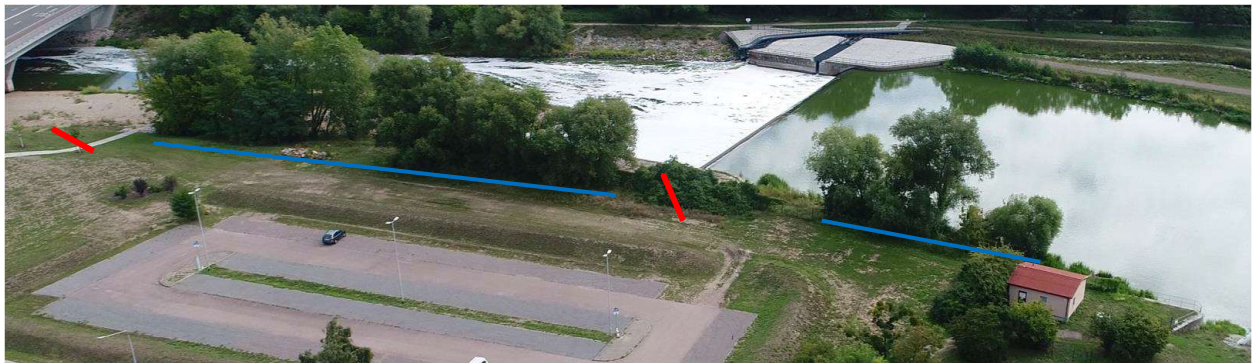
Abbildung 3: Übersicht über das Plangebiet (Foto: Stadt Dessau-Roßlau)
