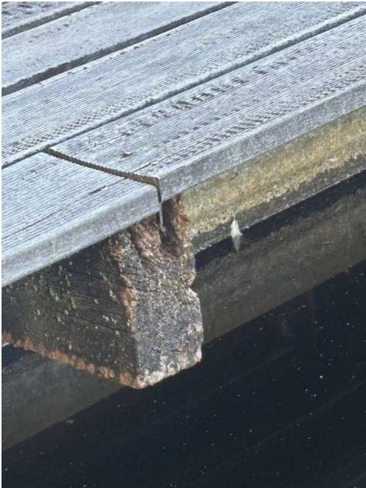
Beschädigung Holzunterkonstruktion
