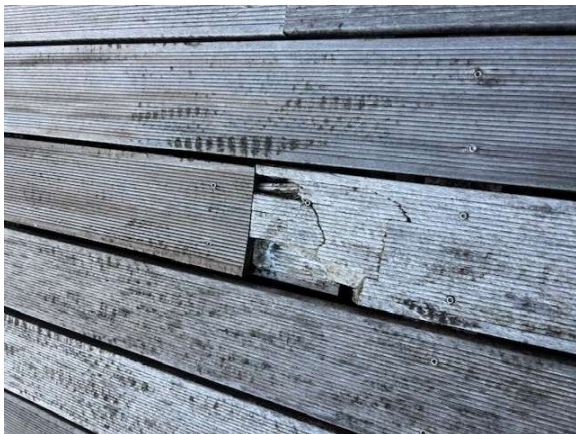
Beschädigung Holzdielung
