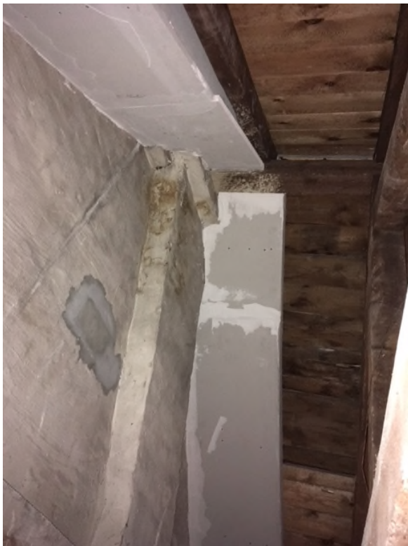
Foto: bestehende Trockenbaukragplatten bei BW 1,2 und 4
