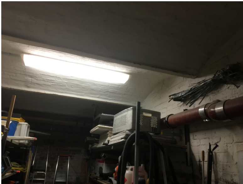
Foto: Trägerdecke KG mit Gewölbe
