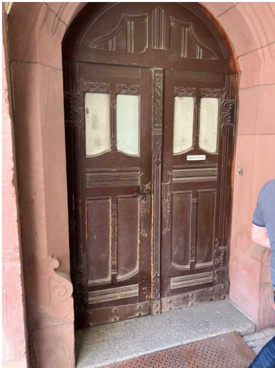
Foto: Tür aus Treppenraum 8 in die Durchfahrt
