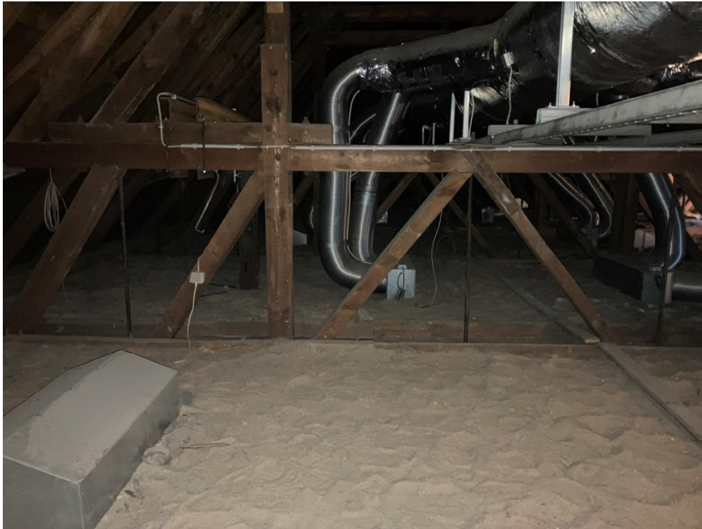
Foto: Decke Ratssaal im DG mit Fachwerkträger als Überzug im gemeinsamen Tragwerk mit dem Dachstuhl
