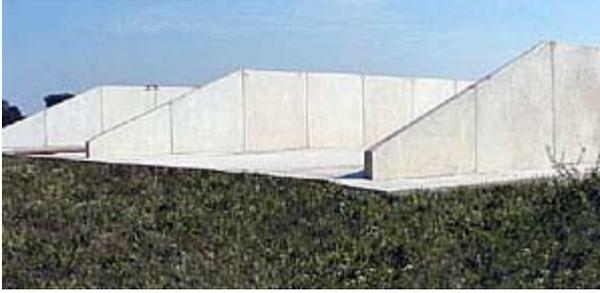
Diese Betriebseinheit dient der Zwischenlagerung von Substraten vom Zeitpunkt der Anlieferung betriebsfremder Stoffe bis zum bedarfsgerechten Eintrag in die Fermentationsanlage.
