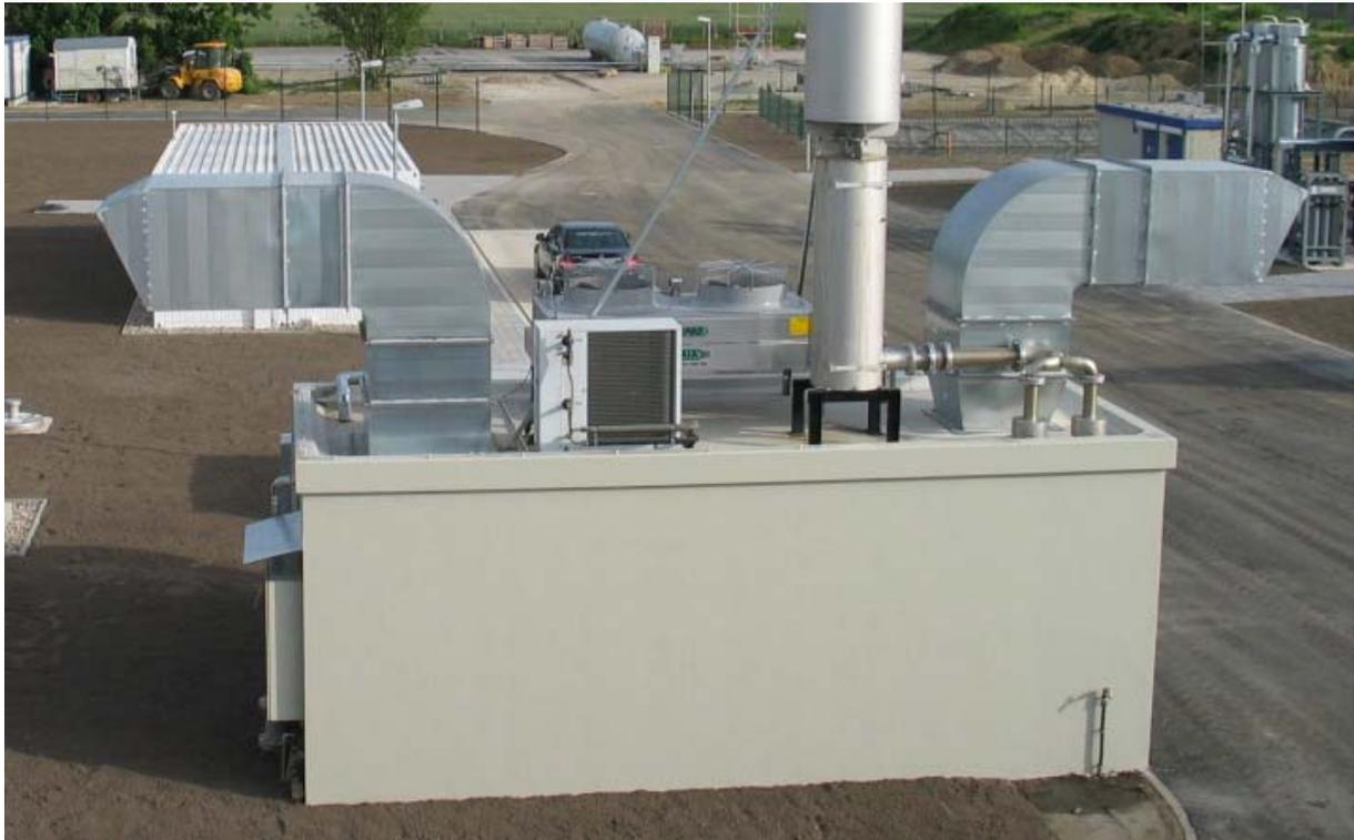
schallgedämmter Container 67 dB(A) in 10 m Entfernung
