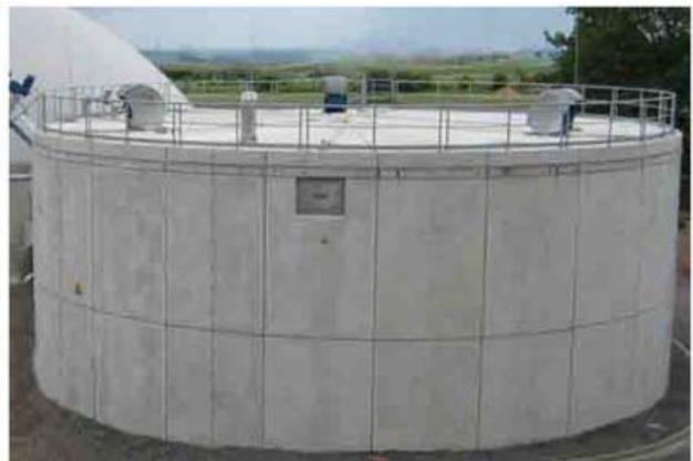
Fermenter (oben 3.300 m<sup>3</sup> max. 6 Paddelrührwerke; unten ggf. 3 Stabmixer)
