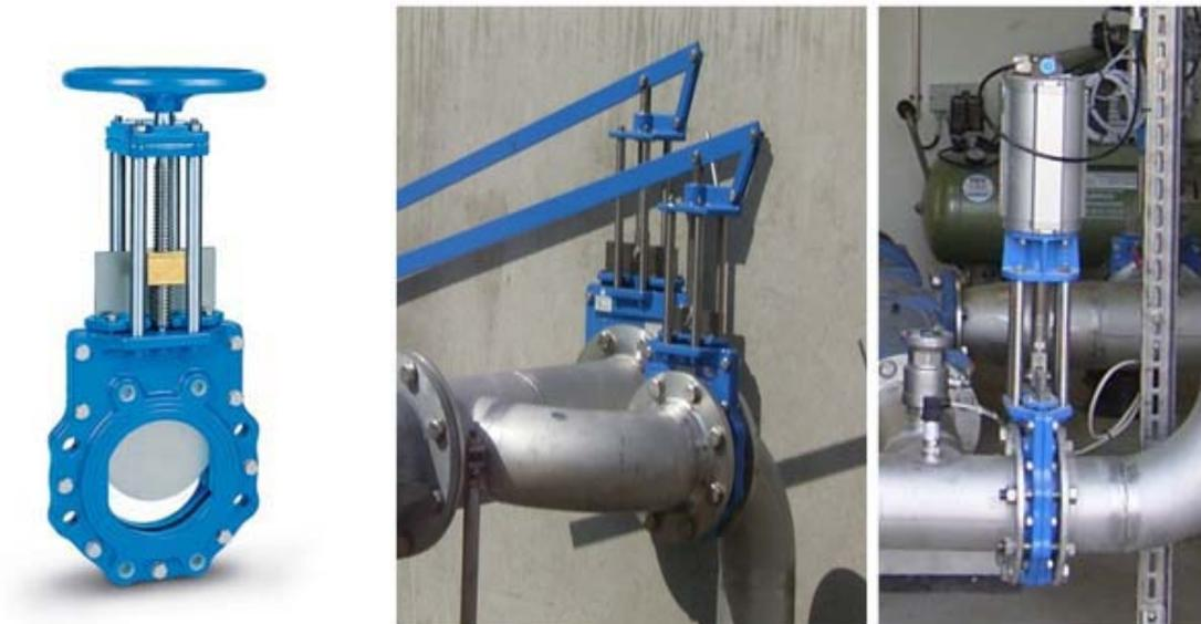
Die am Fermenter installierte Entleerungsleitung DN 150 ist mit einem Schieber in Handradausführung ausgestattet. Dieser muss aus sicherheitstechnischen Gründen stets manuell bedienbar sein.
