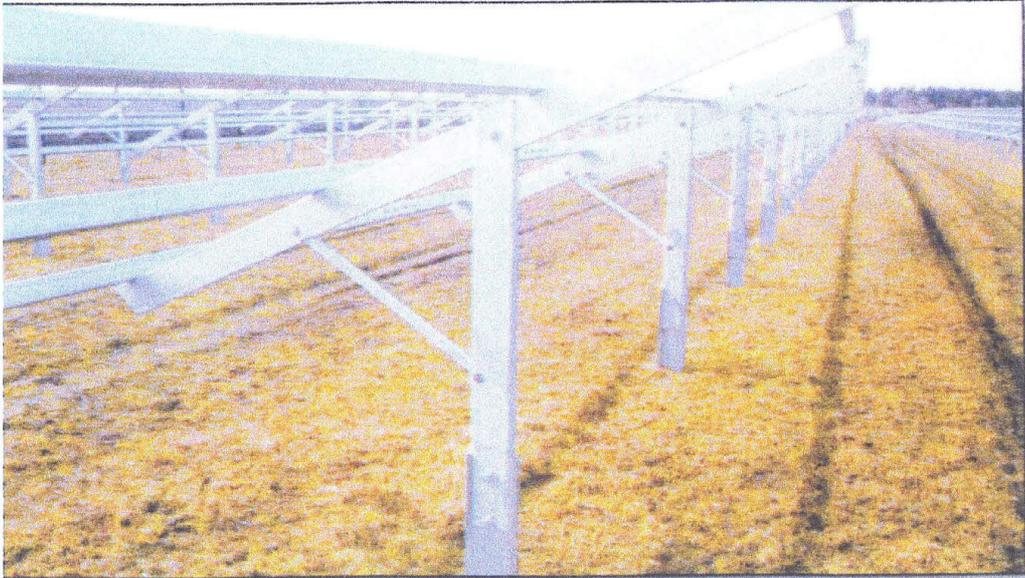
**Abbildung 3 Unterkonstruktion für die PV Module**
