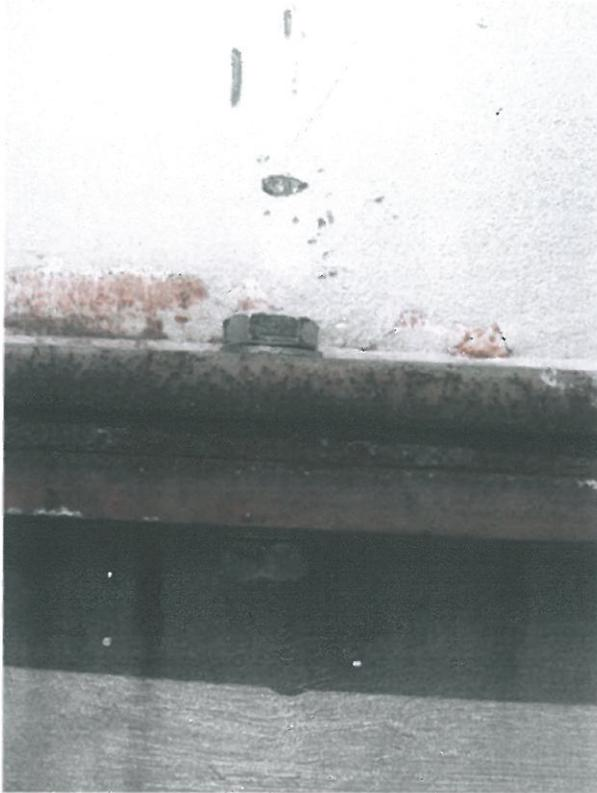
Bild 3: erneuerte Schraubverbindung HT-Fackel
