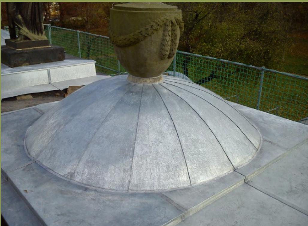
2013: Dachabdichtungsarbeiten auf dem massiven Sandsteindaches des Portalgebäudes
