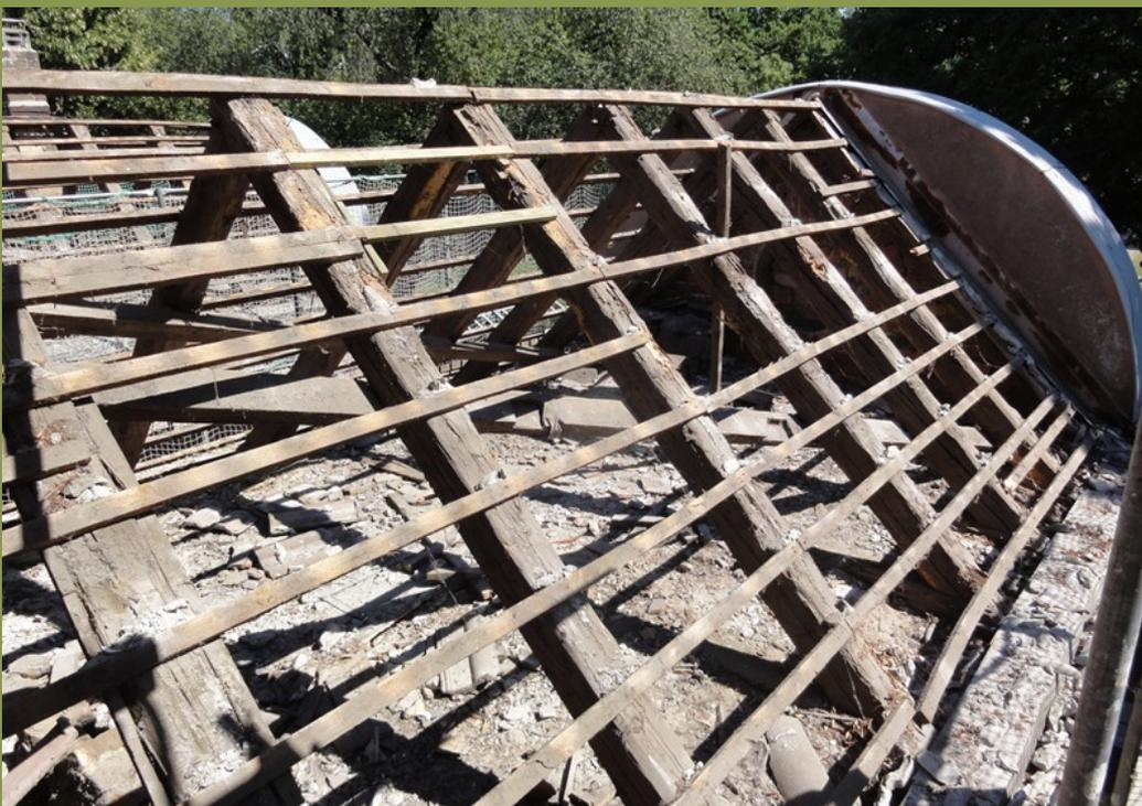
2013: Freilegung und Entschuttung von Dachstuhl und Deckenbalken
