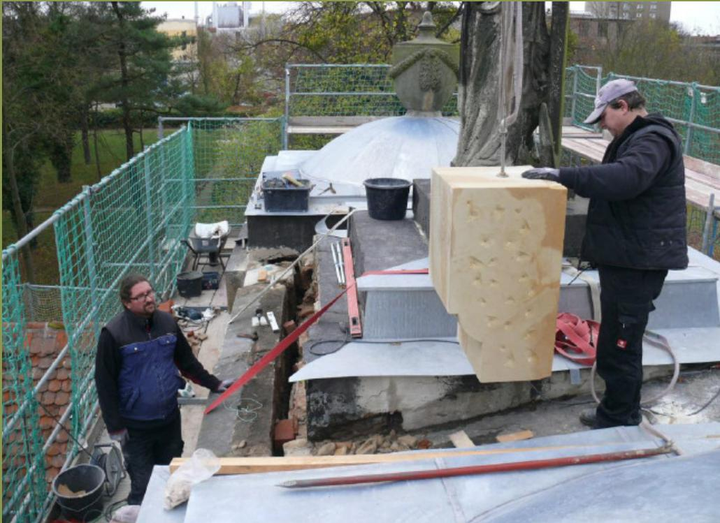
2013: Sicherung und Reparatur des Tonnengewölbes und der darüber liegenden Sandsteinblöcke des Portalgebäudes
